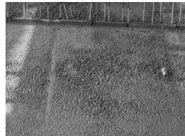
過度なバイブレーター使用による粗骨材の浮き
