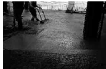
過度なバイブレーター使用による粗骨材の浮き
