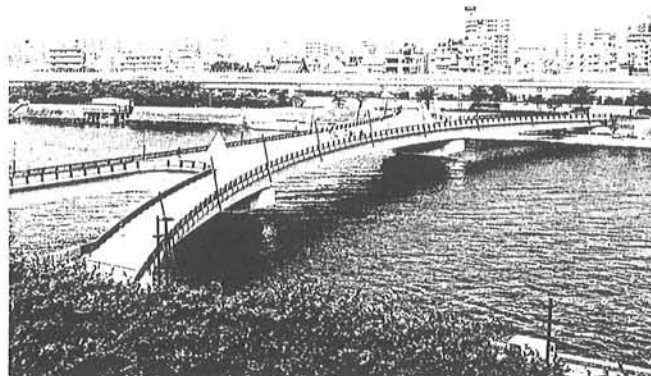
隅田川・桜橋(床版に使用)
