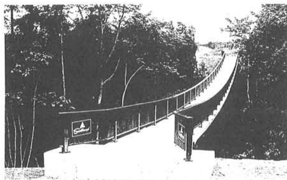
サザンヤードカントリークラブ・つり橋(床版に使用)
