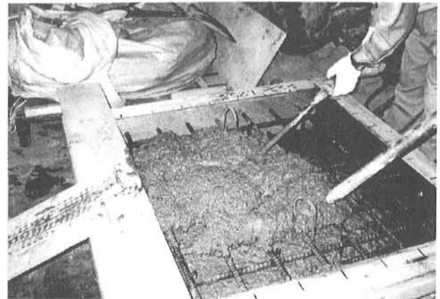
写真-6.2 施工充填性試験
