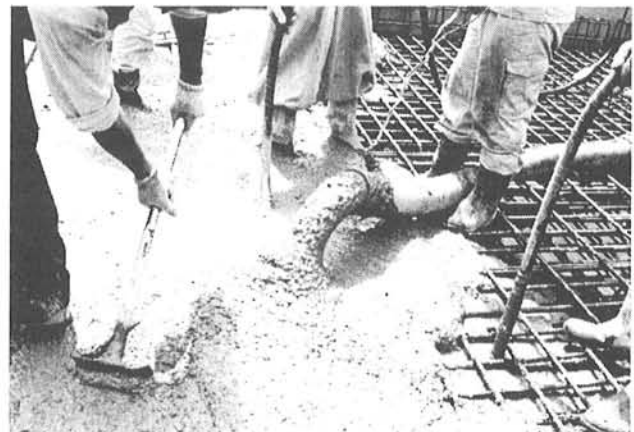
写真-6.3 打設状況
