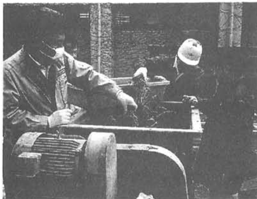
← コンクリートの練り混ぜ状況 SFの投入
